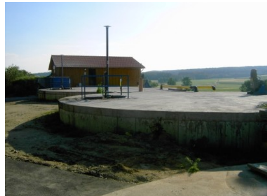
Bild 1: Biogasanlage Beer in Albersrieth
