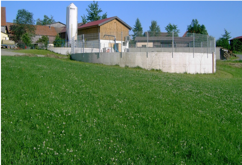
Bild 1: Biogasanlage WKW in Matzersreuth
