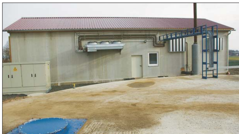
Das Maschinenhaus mit Garage ist eine sehr preisgünstige Konstruktion aus Betonfertigteilen. Fotos: Stadt Mitterteich (1), Wittmann (7)
