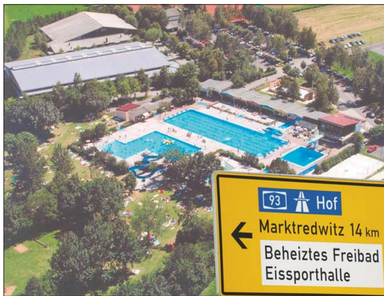
Die Eissporthalle im Winter und das beheizte Freibad im Sommer sind Abnehmer für die Biogasabwärme.
